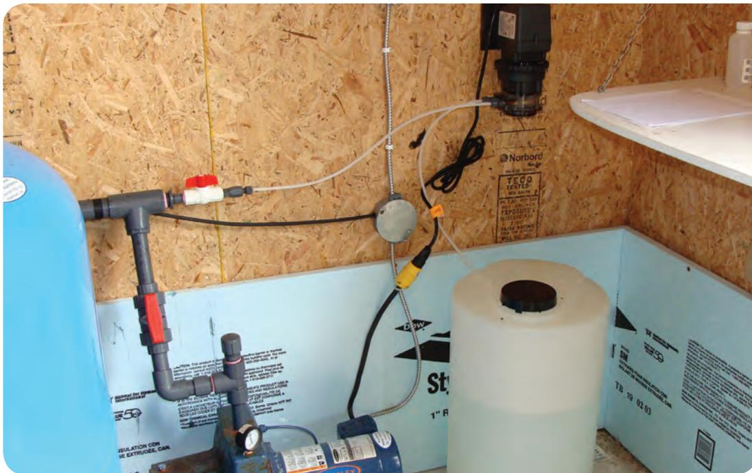
FIGURE 3: CHLORINE INJECTOR
