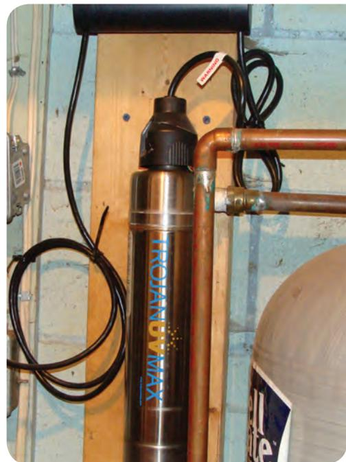
FIGURE 2: ULTRAVIOLET LIGHT SYSTEM
